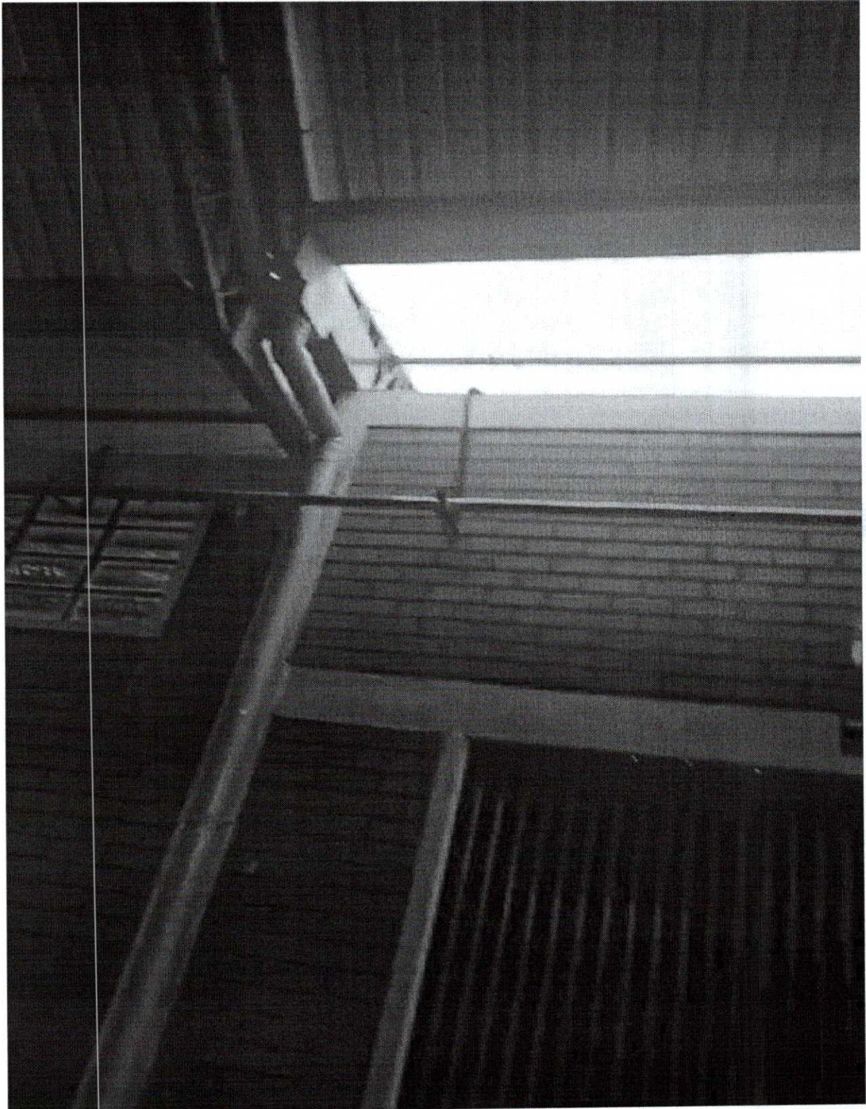
Vista do destelhamento ocorrido na parte interna do barracão.
