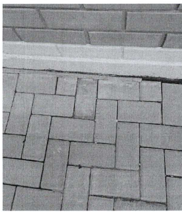
Piso externo oco devido fuga de solo.
